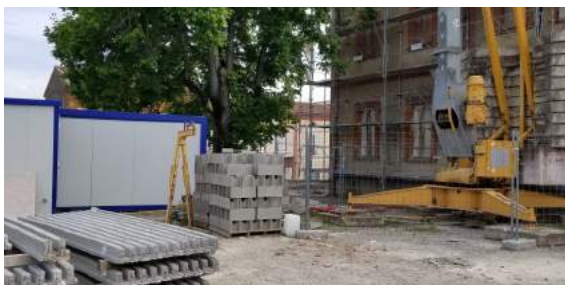
Une vue du chantier
